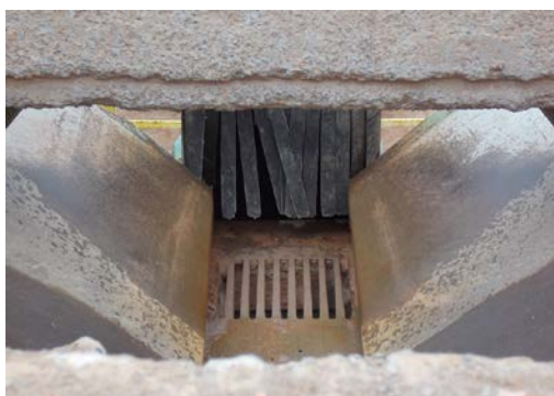
Imagem 5: “Boca” da britadeira. Usina de Reciclagem de Entulhos em Hortolândia.
